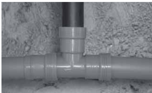
Infiltrationsrören kopplas ihop med hjälp av medföljande delar.
